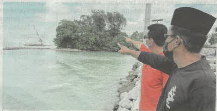
Aziz dan Khairulazni menunjukkan jentera yang digunakan untuk menjalankan kerja-kerja cerucuk bagi pembinaan jeti pelabuhan.
